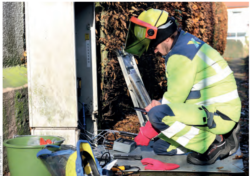
Bild 1. Betriebsmonteur der Stuttgart Netze beim Einbau der Smight-Sensorik in Kabelverteilerschränke
